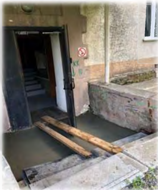
Ремонт входа в общежитие:
