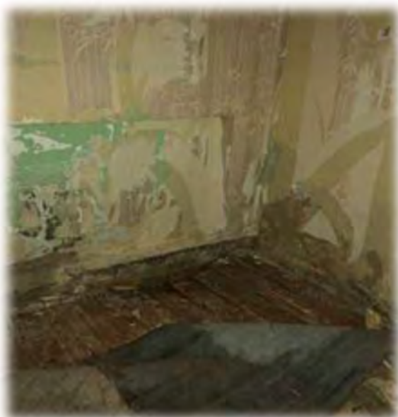
Кабинет 104А до и после ремонта:
