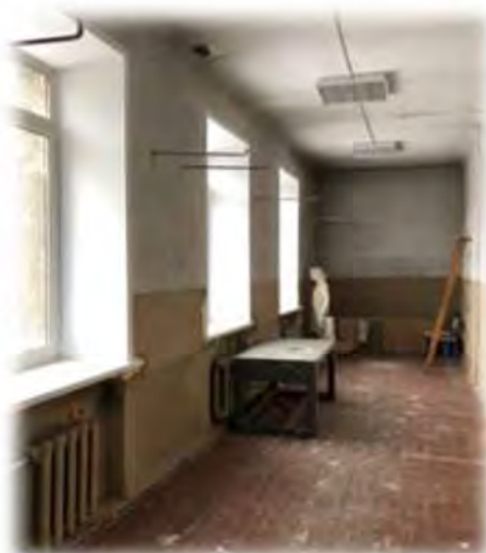
Кабинет 308А до и после ремонта:
